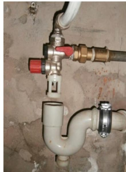
**Hinweis:** Um das Risiko einer Blockierung in offener Position des Ventils des Sicherheitsaggregats zu begrenzen und um dessen Lebensdauer zu verlängern, wird empfohlen, es einmal pro Monat einige Sekunden lang in Betrieb zu nehmen.
